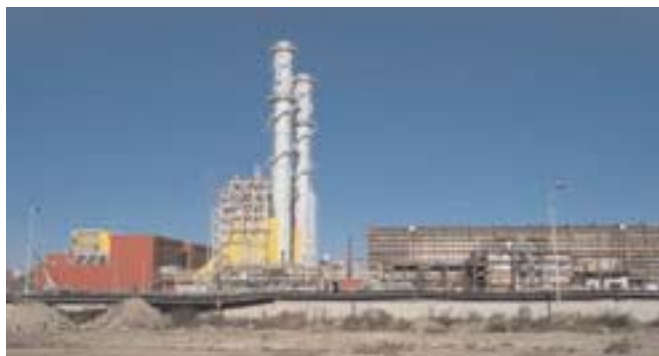
Un'immagine della centrale turbogas di Porto Corsini (RA)
